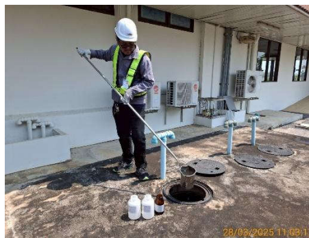
บ่อกักก่อนผ่านระบบบำบัดน้ำเสียอาคารที่พักผู้โดยสาร
